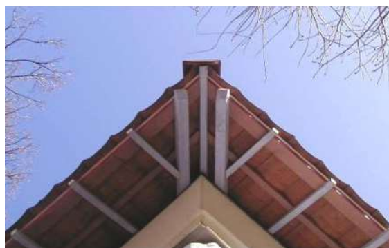
Smäcker och vacker öppen takfot med synliga takpannor
