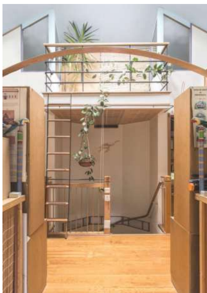
Loftet under takljuskupolen. Notera de två invändiga hörfönstren
