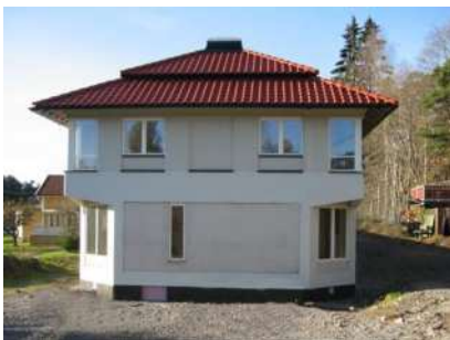
Stomme med fönster och utfackningsväggar monterade
