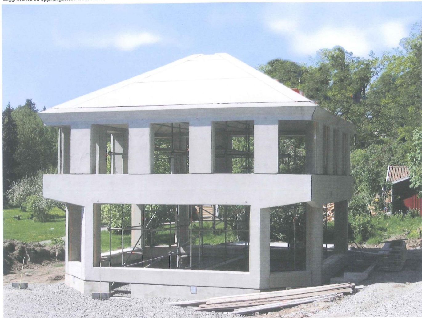
Monterad betongstomme med takelement. Lagg märke till öppningarna i elementen.
